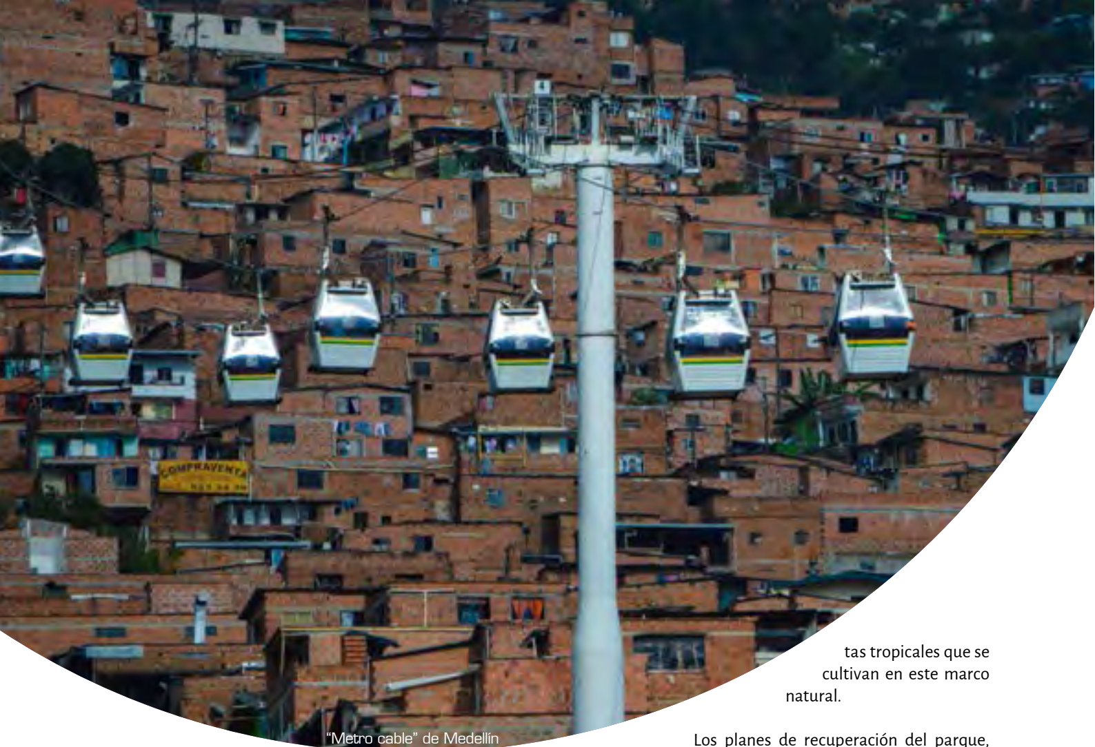
"Metro cable" de Medellín
